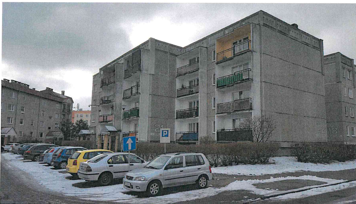
Fot. 1 Elewacja wschodnia i północna
