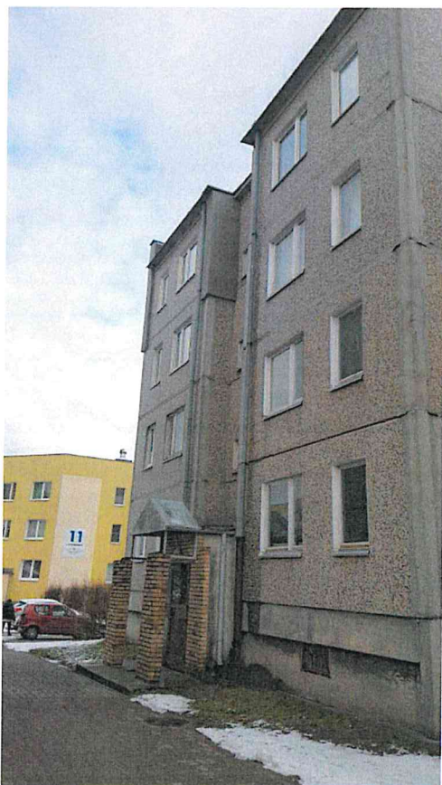
Fot. 2 Elewacja zachodnia
